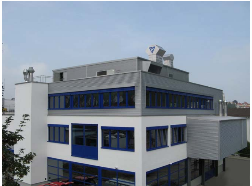
Die neugebauten zusätzlichen zwei Stockwerke des Werkes 2
