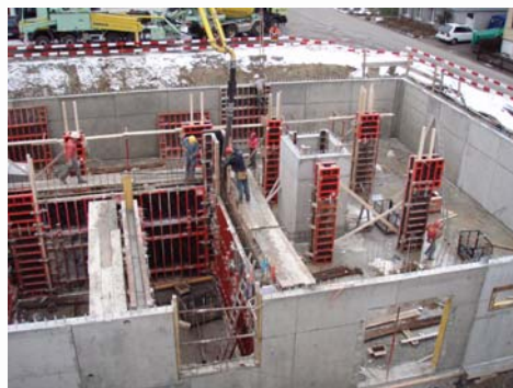
Treppenhaus, an dem der Fertigbau aus Holz "aufgehängt" wird
